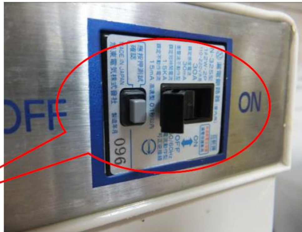
茶水間蒸飯機 漏電斷路器
